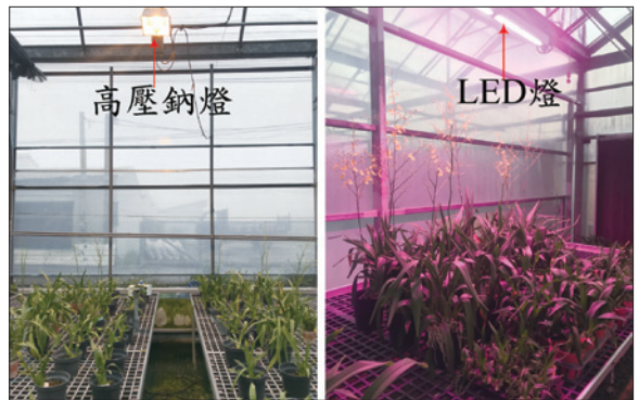
圖9 高壓鈉燈與LED燈具應用架設
