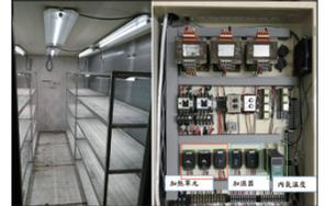
圖4 「節能型多時變嫁接苗癒合室」內部構造及控制機構。
