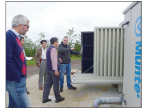
圖23 Munters 公司已安裝於農場使用家禽畜舍通風冷卻及過濾單元。節能降耗之空氣循環，為其家禽畜舍之規畫考量
