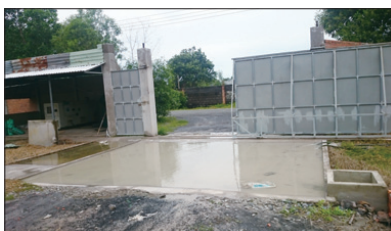
圖15 種鴨場入口處之車輛底盤消毒池
