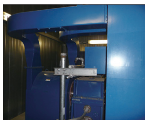
圖19 FibroMinn發電廠蒸汽渦輪發電機
