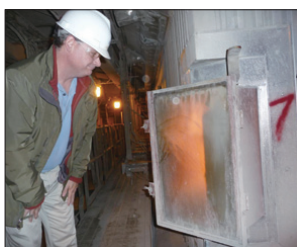
圖21 FibroMinn發電廠鍋爐內燃燒觀察窗
