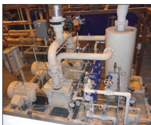
圖17 FibroMinn發電廠蒸汽加壓馬達
