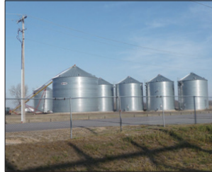
圖29 FibroMinn發電廠鄰近之玉米酒精工廠之玉米儲存筒槽
