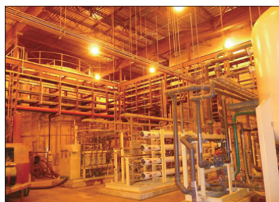
圖14 FibroMinn鍋爐用水之軟、逆滲透及電凝設備(由右而左)
