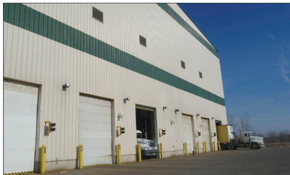
圖11 FibroMinn發電廠集運卡車原料卸貨區外觀
