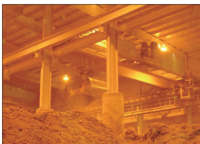
圖13 FibroMinn發電廠集運卡車原料卸貨區內部
