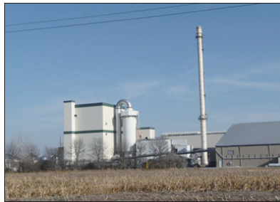
圖3 美國FibroMinn雞糞發電廠外觀(中)及肥料廠(右一)
