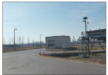
圖7 美國 FibroMinn發電廠集運卡車管制站辦公室
