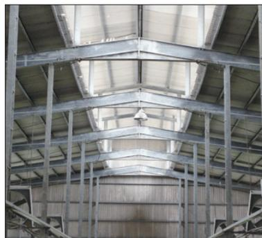
圖6 挑高的太子樓式牛舍設計
