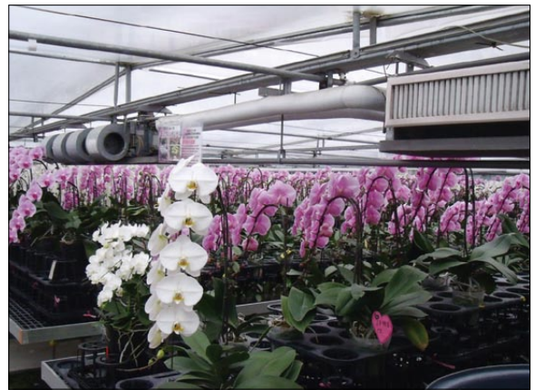
圖14 科隆國際公司溫室之冰水冷氣交換器
