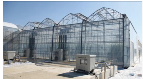
圖20 設置有雨水收集與過濾再利用系統可充份利用水資源
