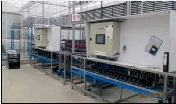
圖8 養液供應控制系統
