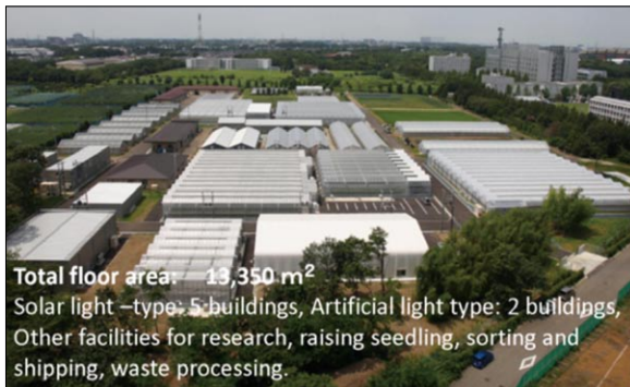
圖18 日本千葉大學植物工場配置圖，其中有5棟為陽光利用型植物工場及兩棟人工光源型(Maruo Toru, Chiba University, Japan)
