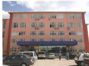
生物系統工程系館大樓
