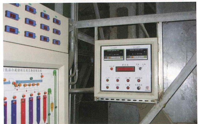
台中縣大安鄉農會低溫暫存筒控制面板及溫度顯示板
