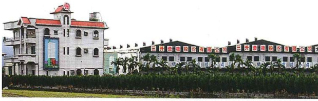
三升公司廠房前景 (左為管理大樓，右為生產工廠)
