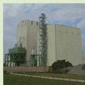
9000t 玉米桶 低溫冷藏儲桶
