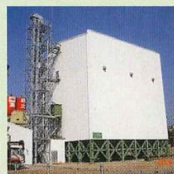
9600t 砂石桶 重載型設備
