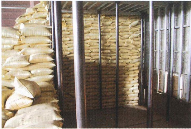
圖一 埋藏鐵架之倉庫現場
