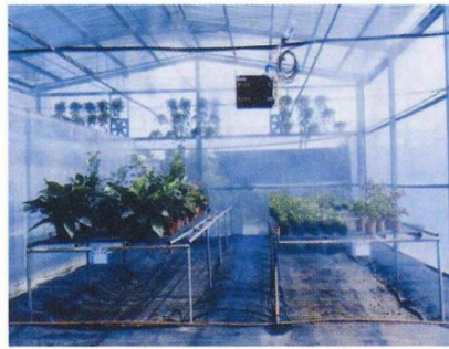
善化牌 SHPI-1 型設施高壓噴霧降溫系統
