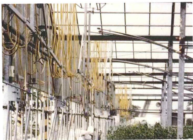
圖一、傳統單棟型懸吊桿式自動噴霧系統在多連棟裝設時需多套噴桿與機組，裝設成本因累加而所費不貲
